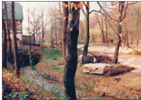
Der begradigte und mit Betongittersteinen begrenzte Rödlitzbach am Parkschlösschen vor der Renaturierung.
