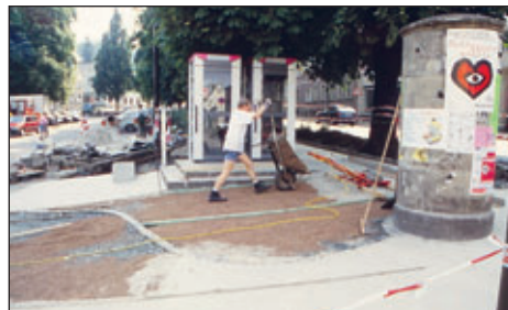
Sanierungsarbeiten im unteren Bereich des Teichplatzes (Foto: Foto Diettrich)
