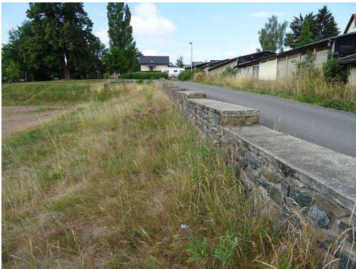
Foto 8: Stützmauer entlang der NW-Grenze des Geltungsbereichs, 06.07.2022.
