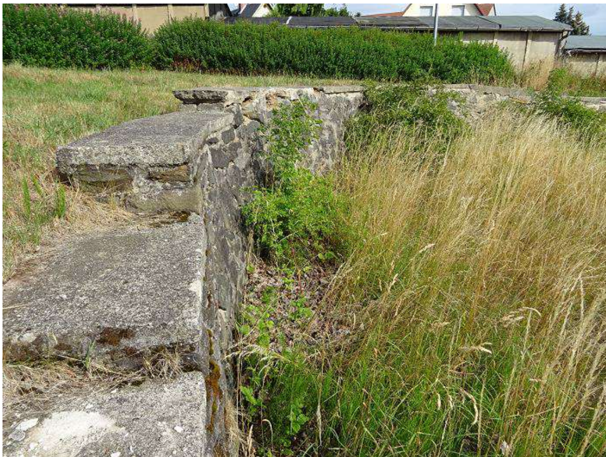
Foto 9: westlicher Bereich der Stützmauer mit Nischen und Spalten als potenzielle Quartiere für Vögel, 06.07.2022.
