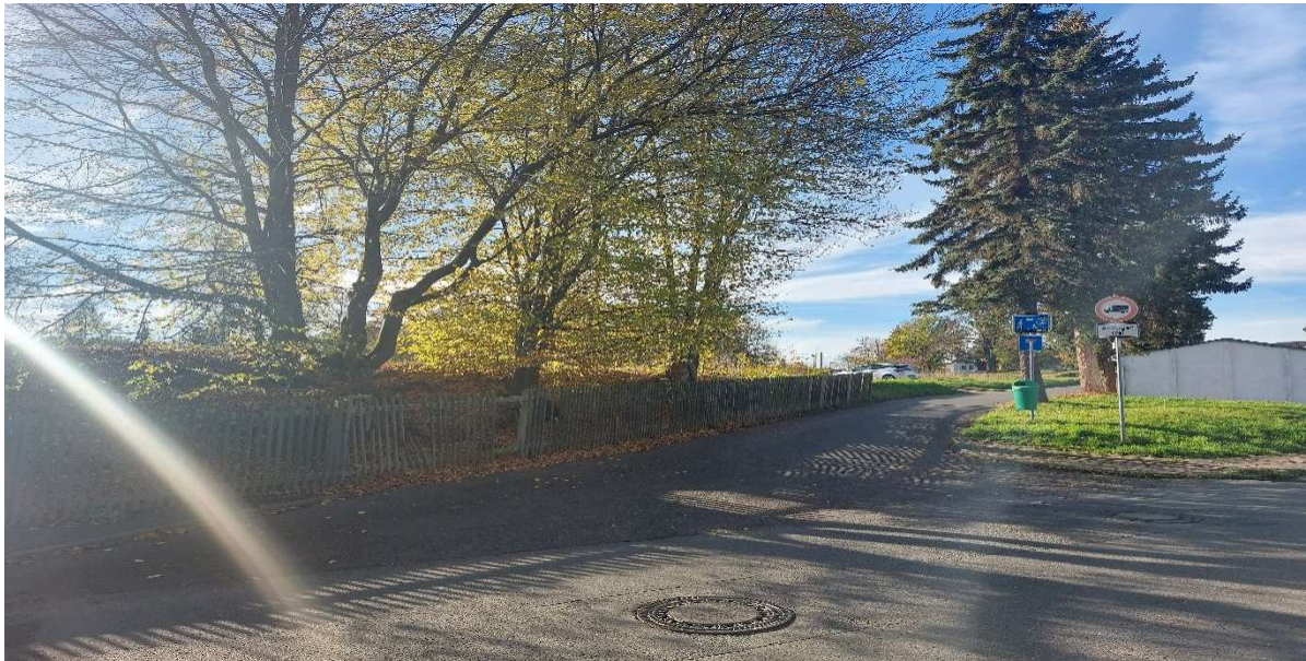
Abb. 8 Ansicht Einfahrtsituation von der Michelner Straße in die Straße „An der Jugendherberge“ Bildquelle: Ingenieurbüro Hubert Beyer
