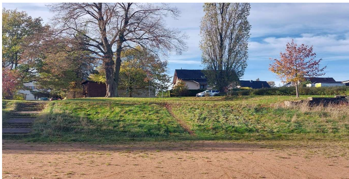
Abb. 7 Ansicht in Blickrichtung Ost, angrenzendes Wohngebiet, Böschungssituation Bildquelle: Ingenieurbüro Hubert Beyer
