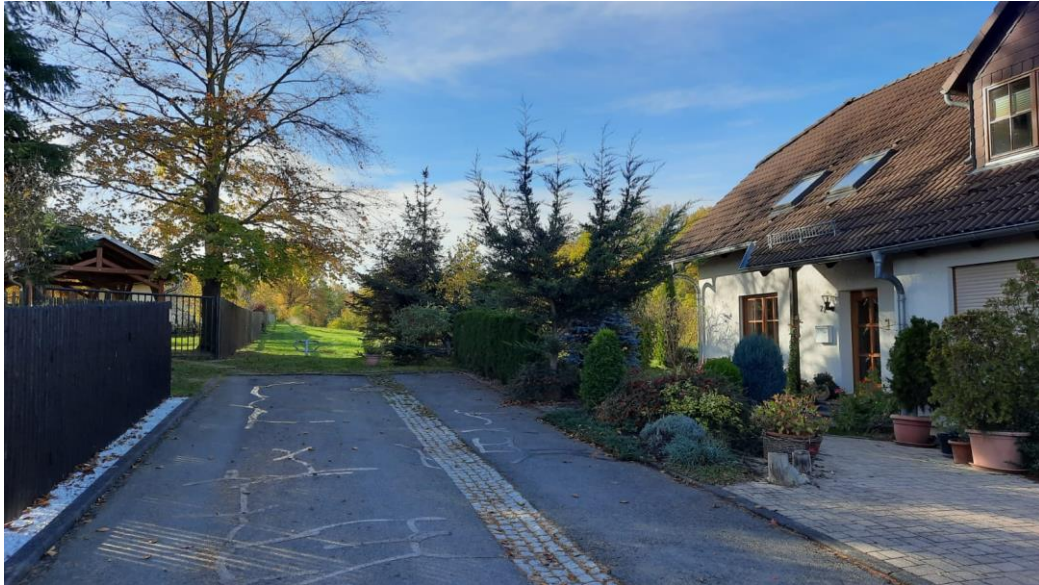
Abbildung 4: Standort der geplanten Wohnbebauung einschl. Erschließung (Foto SCZ vom 11/2022)
